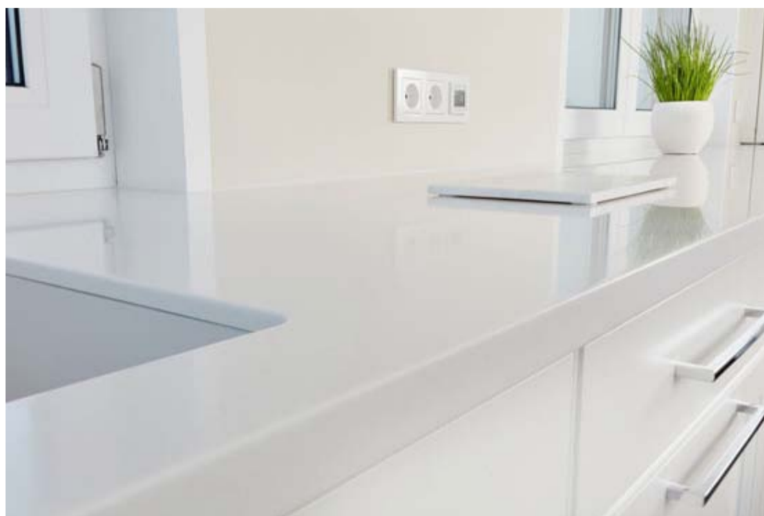
Es findet sich kein Fliesenspiegel, die Arbeitsplatte trifft direkt auf die Wand. Foto: © Michael Sälzer / Beer GmbH
